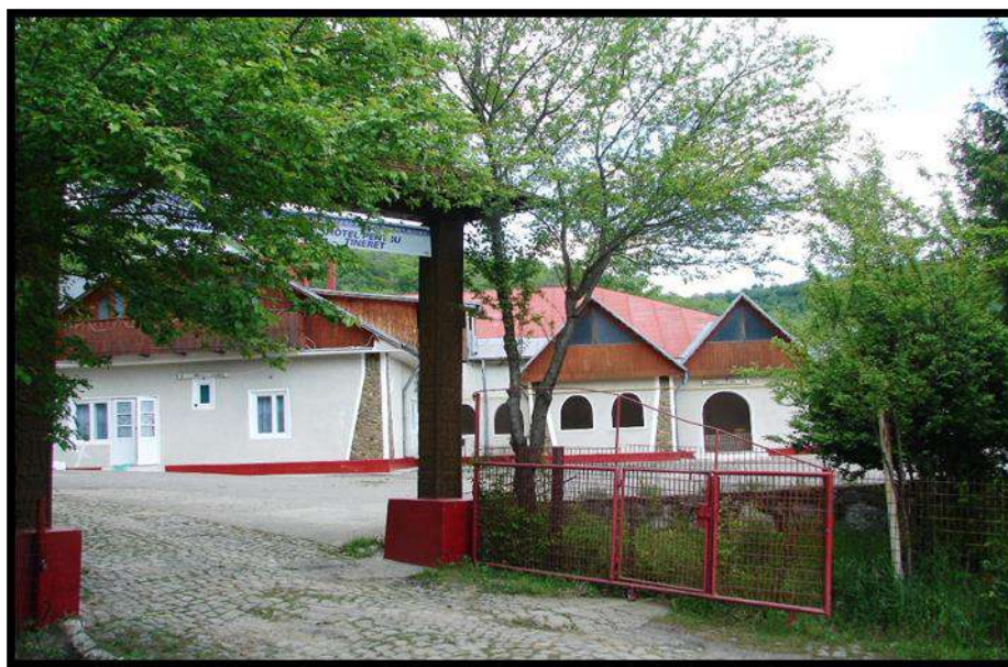
Tabăra Școlară Arbănași
